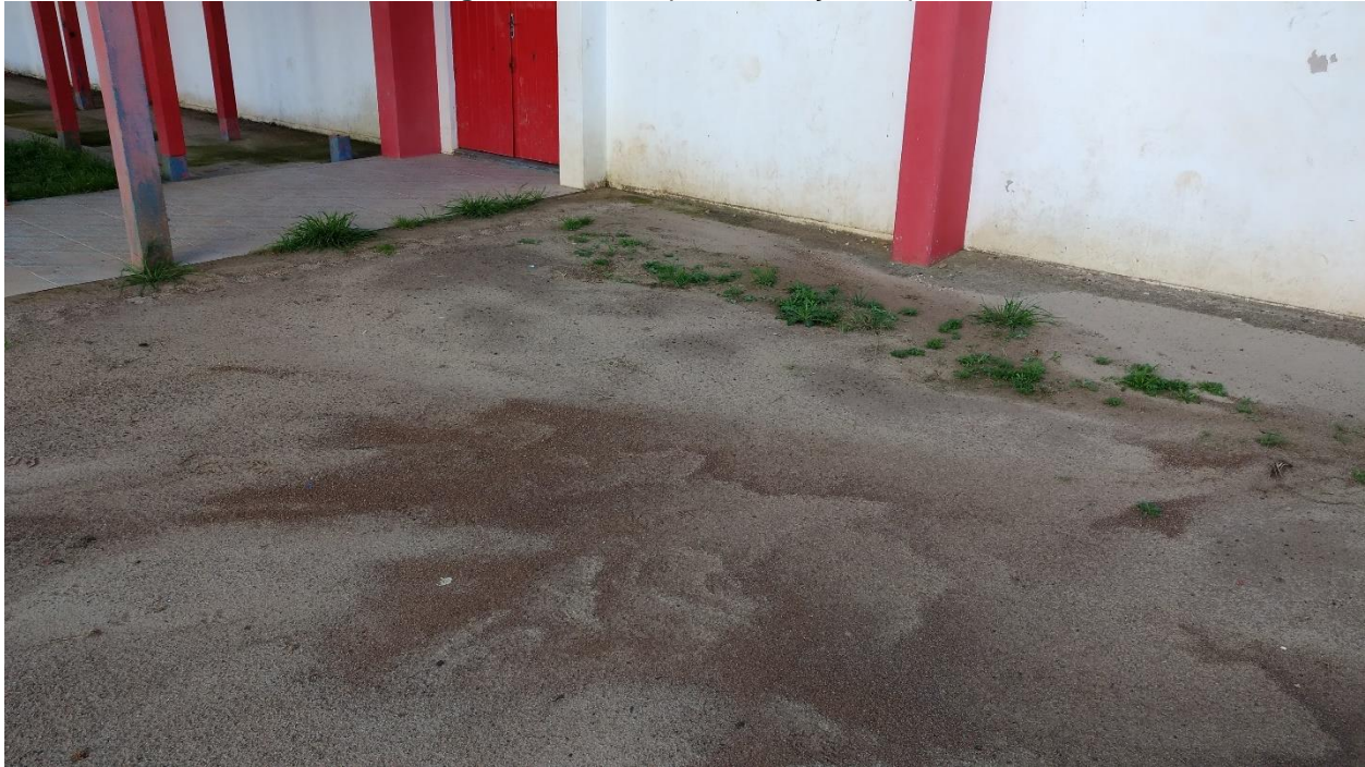
Imagem 03 – Local para execução de piso
