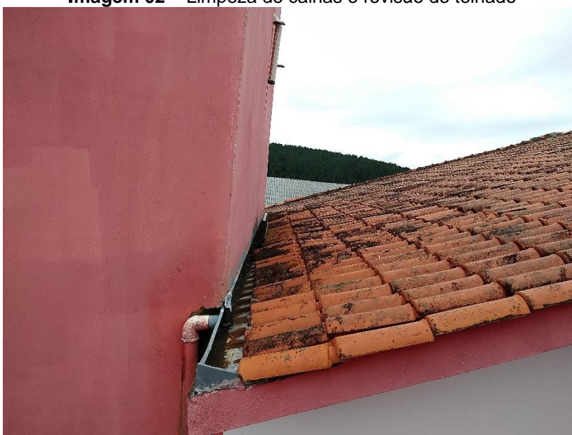
Imagem 02 – Limpeza de calhas e revisão de telhado
