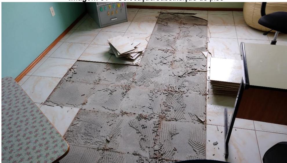
Imagem 01 – Colocação/substituição de piso
