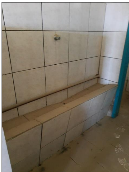
Imagem 11 – Mictório a demolir.
